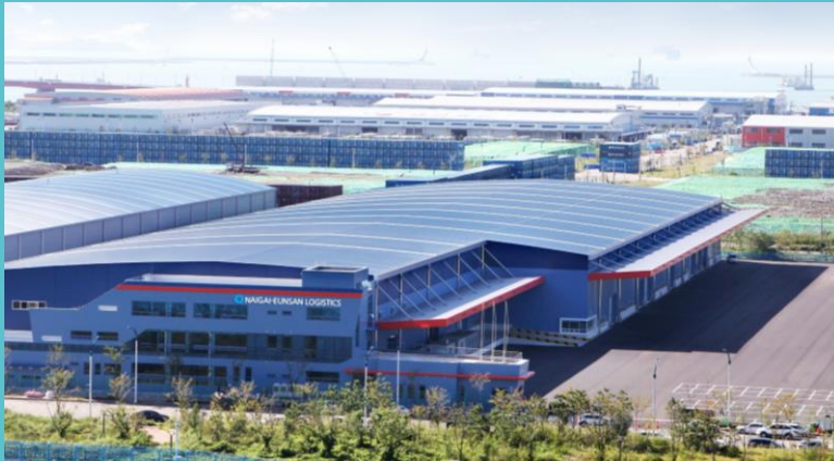
内外銀山釜山倉庫
