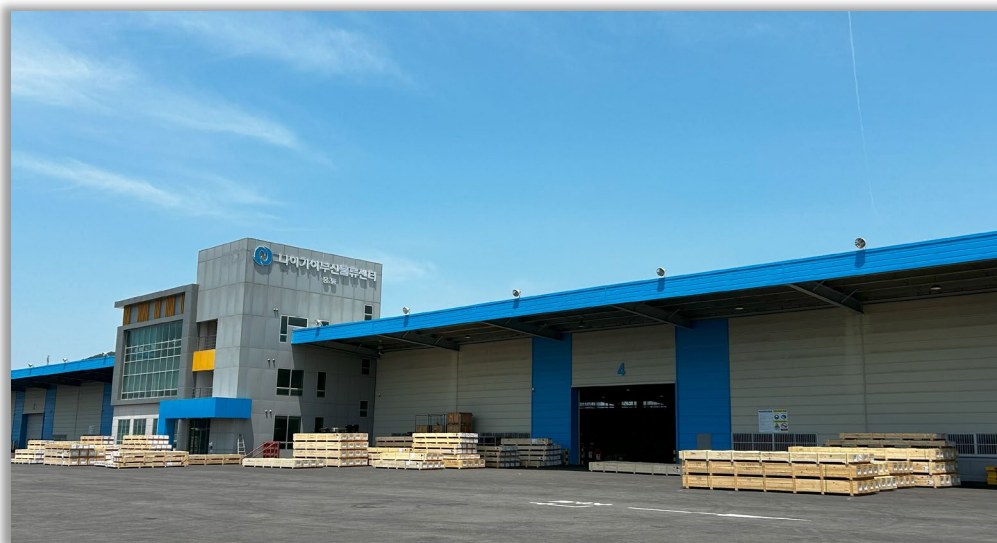
釜山物流倉庫
